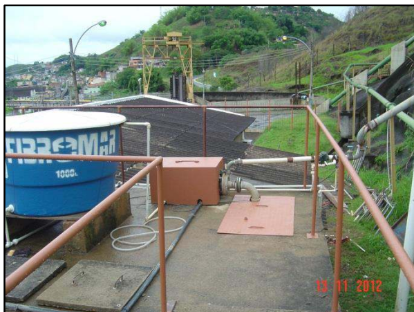
Figura 17 – Reservatório semienterrado anexo a ETA do Horto Florestal – Vista 1
