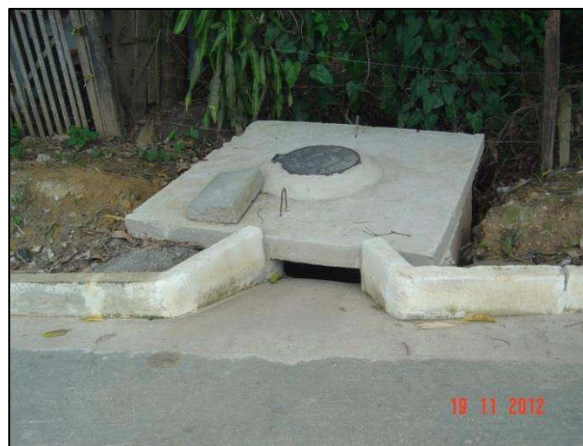
Figura 30 – Boca de lobo localizado no distrito de Vargem Alegre
