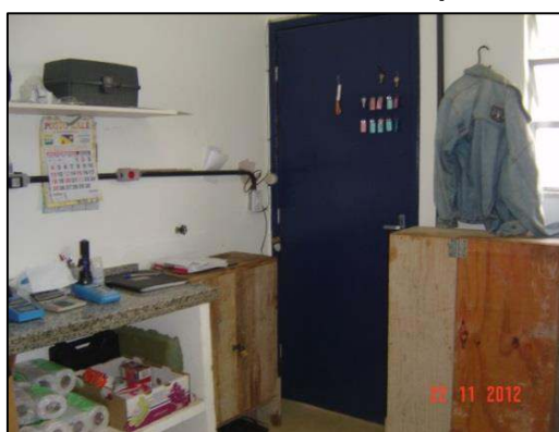
Figura 16 – Casa de Química da ETA Ipiabas – Vista 2
