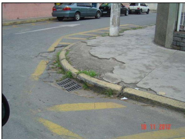
Figura 29 – Boca de lobo localizado no distrito Sede
